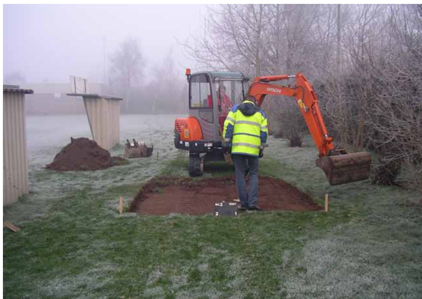
Figuur 5.2. Het aanleggen van werkput Su2.2.
