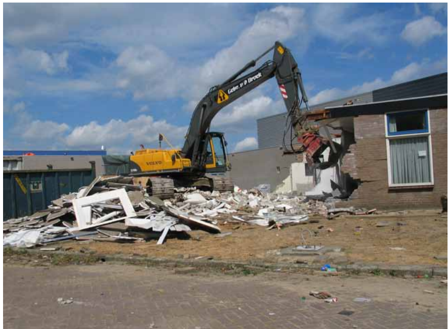
Figuur 3.1. Het slopen van de oude kantine.
